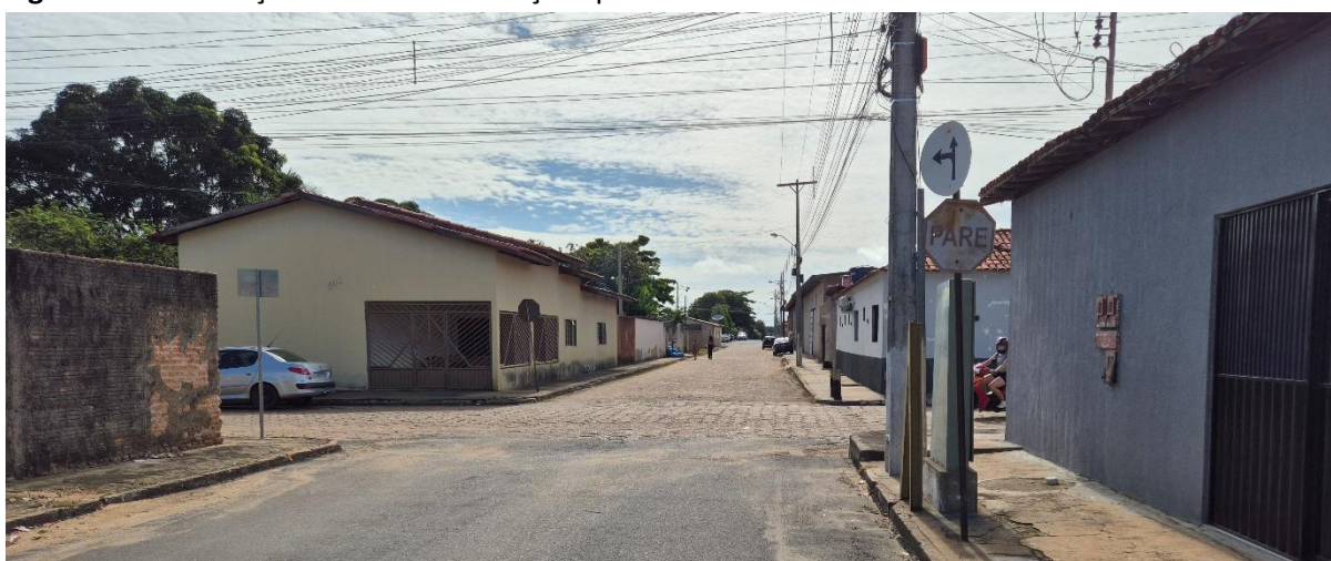
Figura 171. Sinalização vertical em condições precárias.
