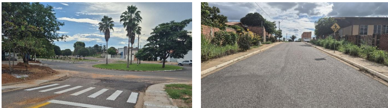
Figura 71. Imagens de obras recentes de recapeamento asfáltico e construção de calçadas
