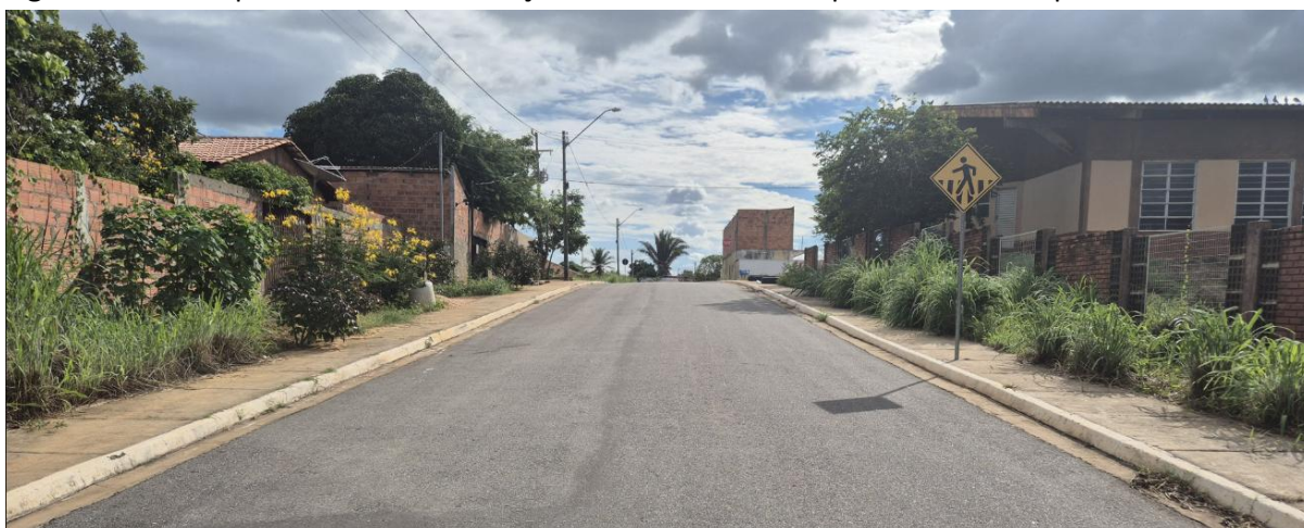
Figura 172. Incompatibilidade de sinalização vertical e horizontal para travessia de pedestres.
