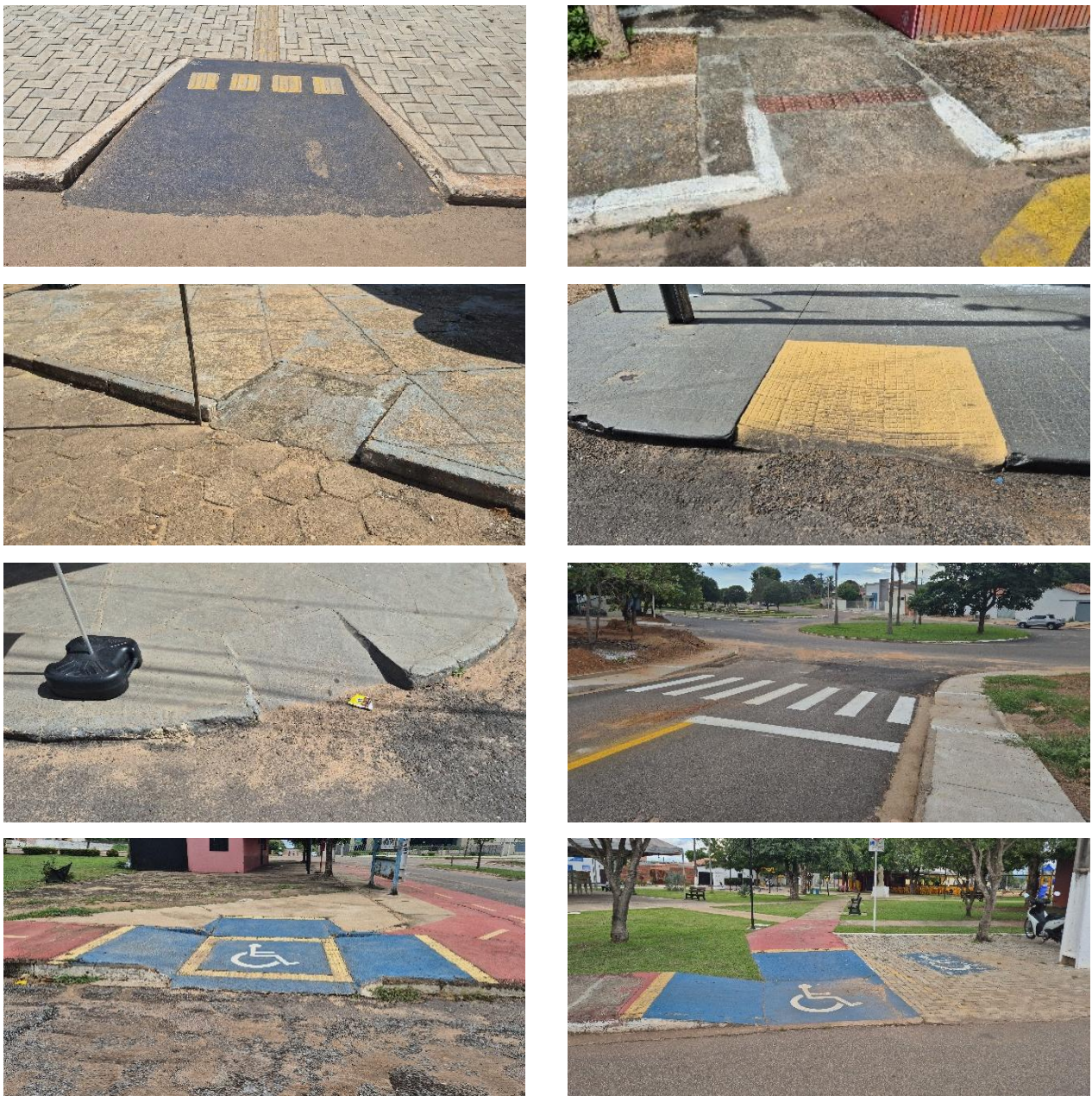
Figura 74. Rampas de travessia de vias em Miracema do Tocantins
