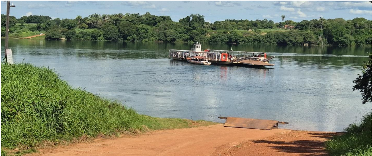
Figura 143. Balsa em operação entre Miracema do Tocantins e Tocantínia.
