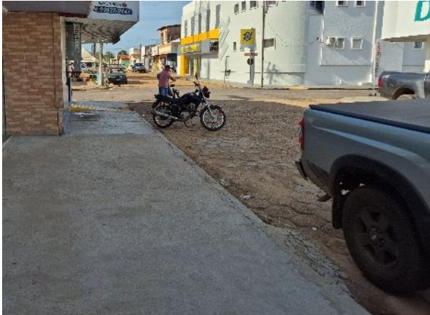
Figura 75. Rampas de acessibilidade inadequadas
