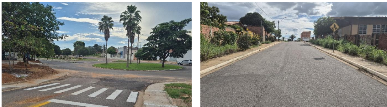
Figura 71. Imagens de obras recentes de recapeamento asfáltico e construção de calçadas
