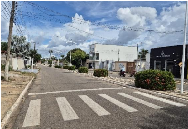
Figura 76. Faixas de pedestre sem rampas de acessibilidade
