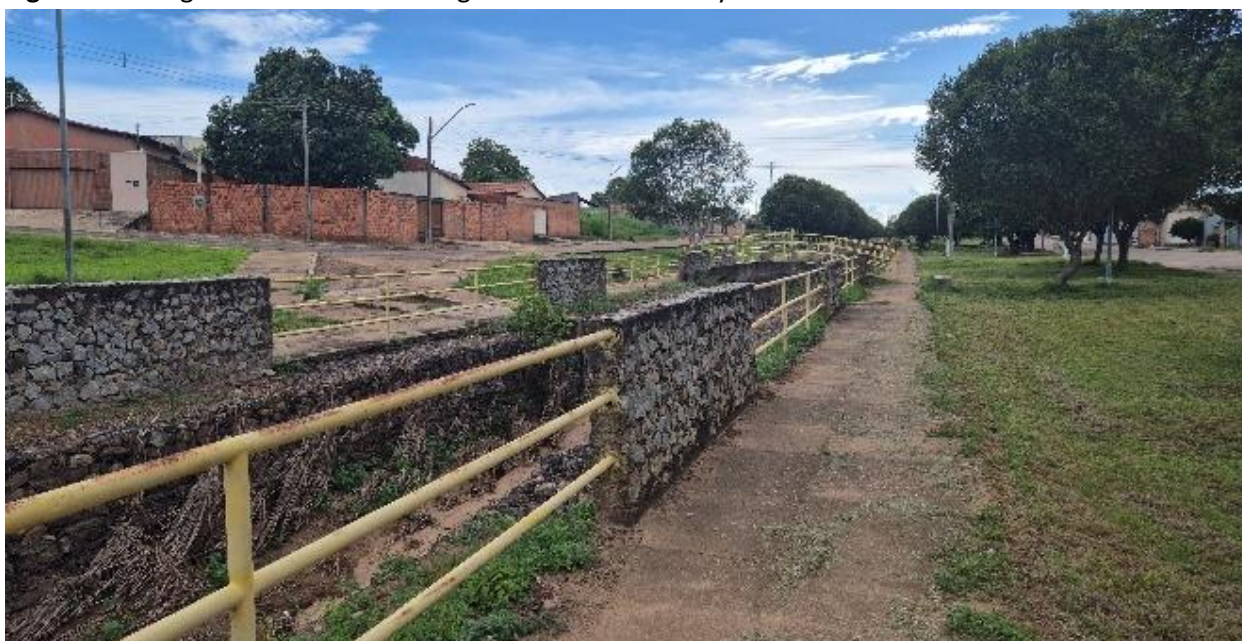
Figura 10. Imagem do canal de drenagem no Setor Flamboyant
