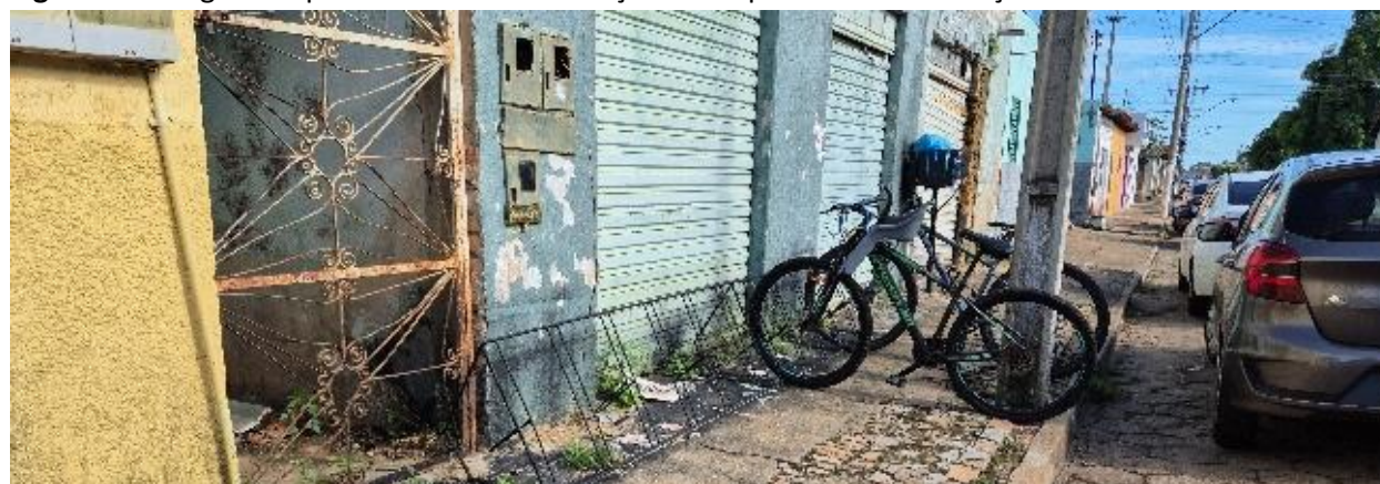
Figura 89. Imagem de paraciclo sem manutenção e mal posicionado na calçada.
